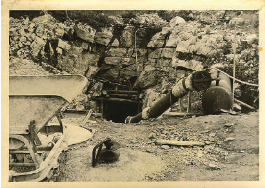
Perçement du tunnel d'accès
